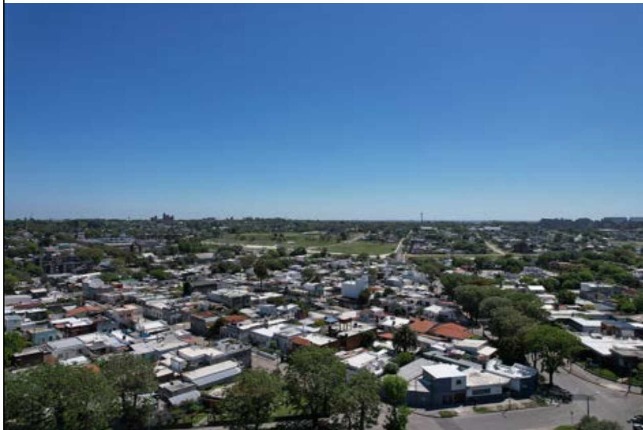
VISTA CONTRAFRENTE NIVEL 05
