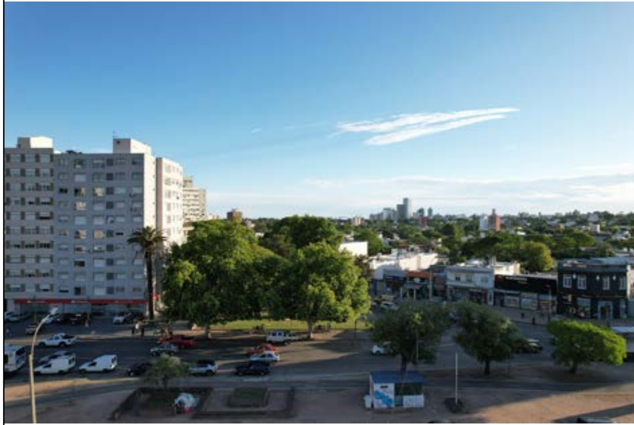
VISTA FRENTE NIVEL 05
